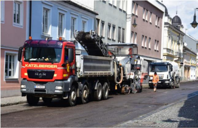
Nach Abschluss der Grabungsarbeiten für die Wasserversorgung im Stadtzentrum wurde von der Stadtbrücke bis zur Daringer-Kreuzung eine komplette Belagssanierung durchgeführt.
